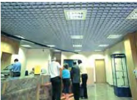
**Tile Tegular**, painéis metálicos, liso ou perfurado, apoiados simplesmente em perfis T 15mm, criando um rebaixo em torno do painel.
