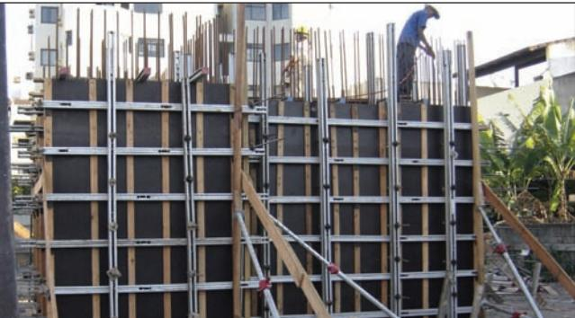
Produto desenvolvido exclusivamente para o uso em fôrmas de concreto, apresentando selamento em suas bordas com tinta especial na cor branca, que auxilia na proteção contra umidade, tornando os painéis mais resistentes e com baixo índice de inchamento.
